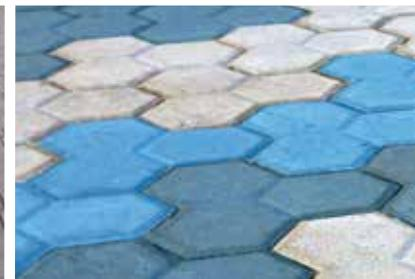
São amplamente utilizados em estacionamentos, calçadas, parques e praças; além de serem ideais para a pavimentação de ruas, avenidas e até aeroportos. Proporcionam temperatura mais amena, permitem a absorção da água da chuva e exigem pouca manutenção.
